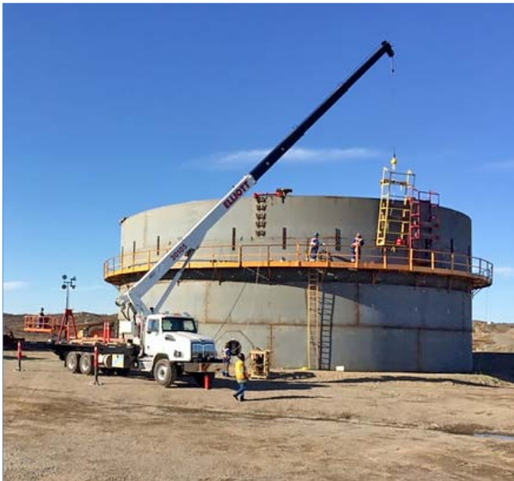
Un nouveau réservoir de stockage du carburant a été construit à Iqaluit en 2019.
