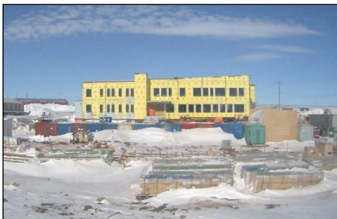
Construction du nouveau siège social à Baker Lake
